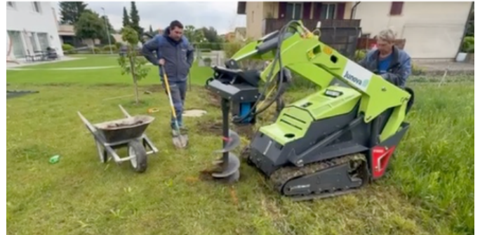
Pfostenlöcher bohren
